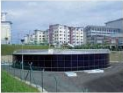
Tanque de Agua Potable - Malasia
