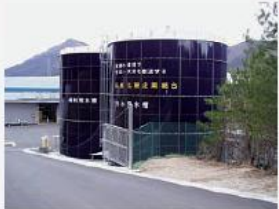
Tanque Agua Residual - Japón
