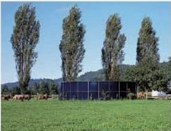
Tanque de Lodos - Suiza
