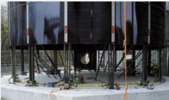
Instalación con Gatos Mecánicos
