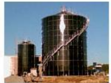
Tanque Digestor - Estonia
