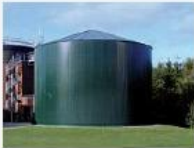
Tanque Digestor - Alemania
