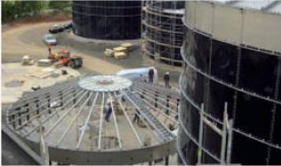
Instalación del Techo
