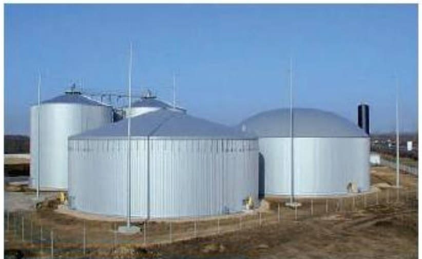
Planta de Biogas - Austria
