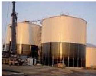
Planta de Biogas - Austria
