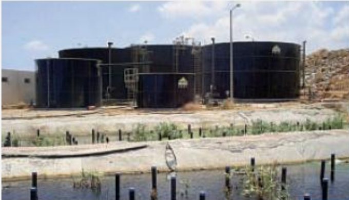
Planta Tratadora de Aguas Residuales – Grecia.
