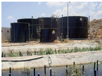
Водосборник очистных вод, Греция
