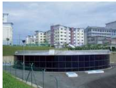
Резервуар-накопитель питьевой воды, Малайзия
