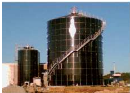
Смесительный бак ферментационной установки, Эстония
